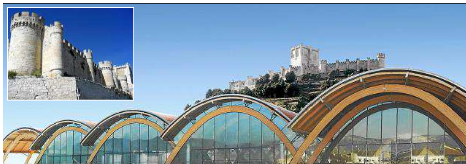
Las nuevas instalaciones de las Bodegas Protos, a los pies del Castillo de Peñafiel, en detalle a la izquierda.
