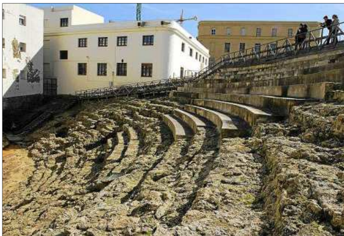
Restauración del graderío, con el que se funden los edificios circundantes.
